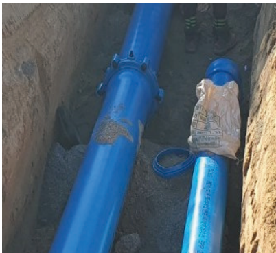
☞ 지상에 적치된 관로를 내려 굴착면 아래에 설치
