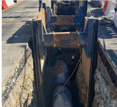
☞ 굴착면 붕괴방지 위해 관로 흙막이 설치
