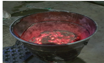
[갈탄 콘크리트 양생 장소]
