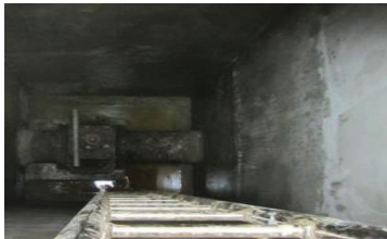
[지하 공동구 박스 내부]
