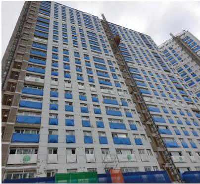
외부 벽체 도장 공사
