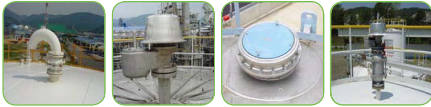
통기관 (Vent) 통기밸브 (Breather Valves) 비상(긴급)통기설비 (Emergency Vent) 통기밸브와 역화방지기 (Flame Arrester)
