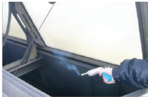
스모크 건을 이용한 기류 확인
