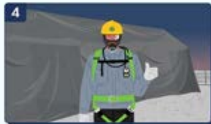
4 일산화탄소 농도가 기준을 초과한 경우 송기마스크 또는 양압식 공기호흡기를 착용하고 양생내부 출입
