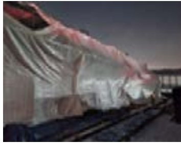
[ 콘크리트 보온양생 장소 ]
