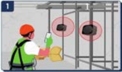
1 양생작업 전 양생공간 내부에 일산화탄소 감지기 설치 (면적을 고려하여 양생작업 내부에 최소 2대이상 설치)
