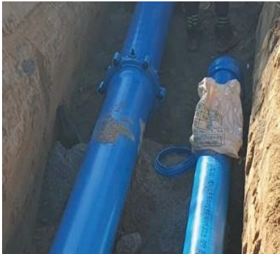
Burial of pipeline 관로 매설
