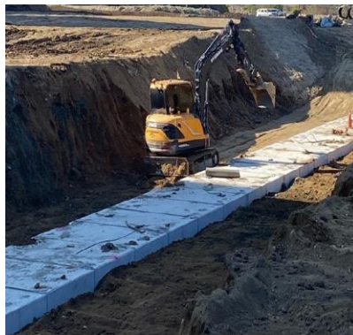
Backfill 되메우기
