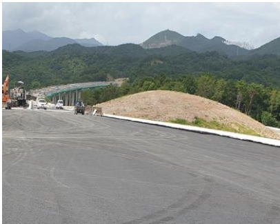
Pavement of bridge deck 교량상판 포장
