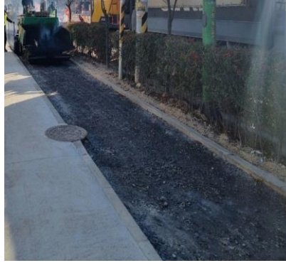
Road pavement 도로포장
