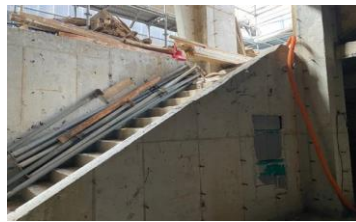
[Leading edge at the side of stairway 계단 측면 단부]
