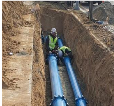
Installation of pipeline 관로 설치
