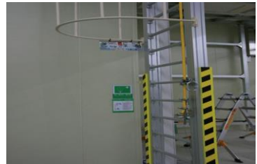
[Fixed ladder 고정식 사다리]
