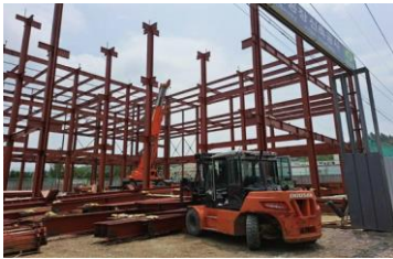
[Steel column and beam 철골 기둥 및 보]
