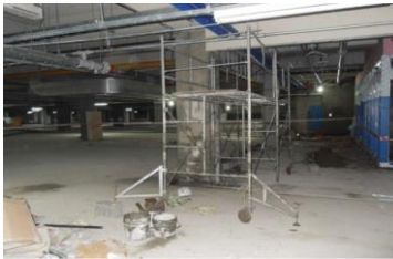
[Mobile scaffolding 이동식 비계]
