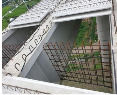
Construction of cross beam and slab 크로스빔 및 슬래브 시공
