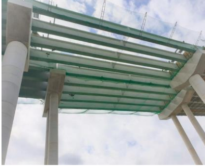
Installation of girder 상판 거더 설치
