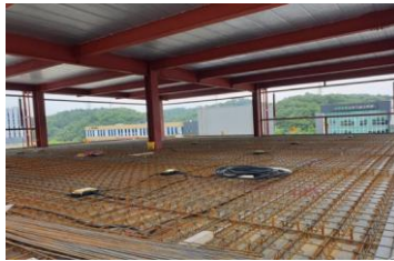
[Deck platform (floor) 데크플레이트(바닥)]
