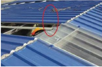
[ Warehouse roof (panel) ] 청고 지붕(패널)
