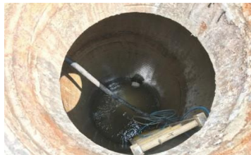
[Inside manhole 맨홀 내부]
