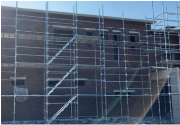
[System scaffolding 시스템 비계]
