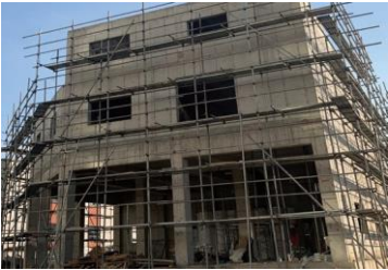
[Steel tube scaffolding 강관 비계]
