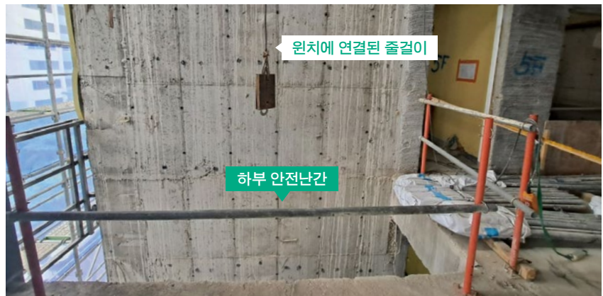
상부 안전난간이 제거된 모습
