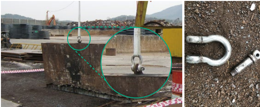
올바른 중량물 연결 방식은 러그에 바로 섬유벨트를 묶는 게 아니라 샤클을 사용해서 걸어야 한다 샤클
