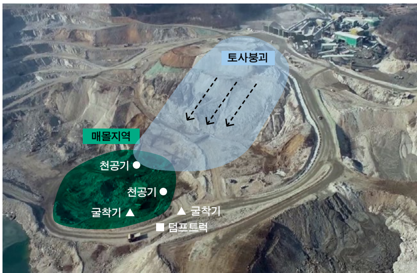
토사가 흘러내린 재해 현장
