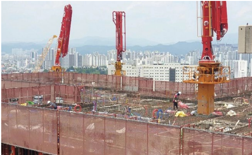
고압으로 콘크리트를 붓는 장비를 이용해 콘크리트 타설 작업이 이루어진다
