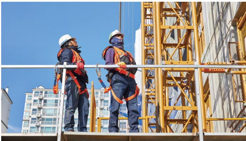
해당 사고와 유사한 작업 현장에서 안전대를 걸고 작업하는 모습
