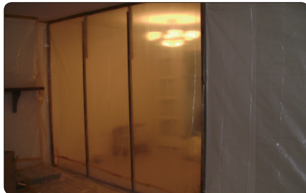
[그림 6-4] 임시벽 설치 사례
