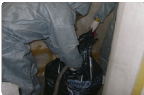
[그림 10-4] 석면폐기물 포장용기 이중 밀봉방법
