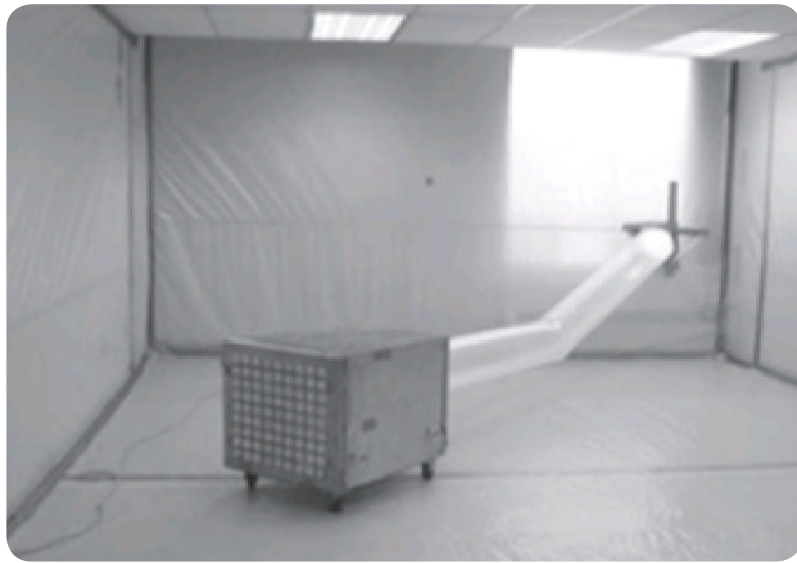
[그림 8-3] 음압기 배출덕트로 비닐사용 예시
