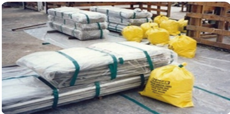
[그림 10-10] 포장된 폐슬레이트와 잔재물
