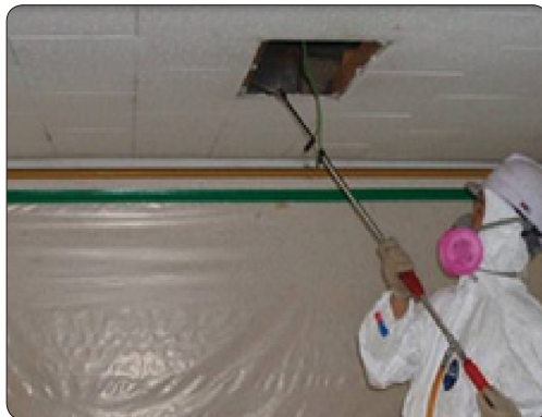
[그림 9-3] 코팅된 천장 텍스 뒷면의 습윤제 분무 예시
