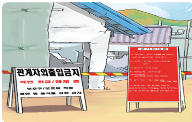
[그림 2-3] 석면해체제거 작업장 바리케이트 및 경고표지 설치 예
