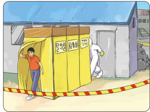
[그림 5-2] 지붕슬레이트 해체·제거작업 인근에 설치된 위생설비
