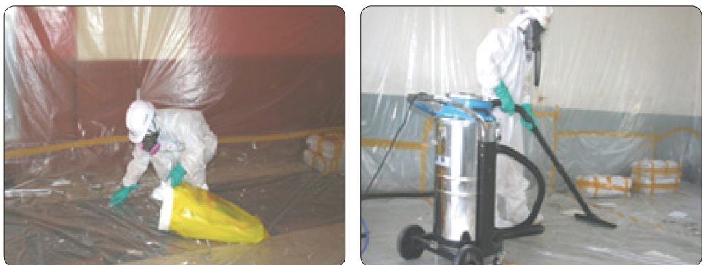
[그림 10-3] 석면함유 잔재물의 청소 모습
