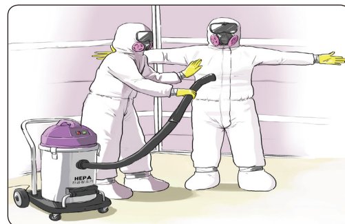
[그림 5-3] 작업장 이동 전 석면분진 세척모습
