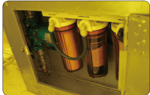
[그림 5-5] 냉온수기 및 배수여과장치 설치 예
