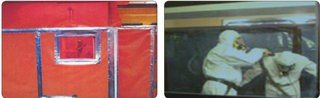
[그림 7-3] 감시창 설치 사례
