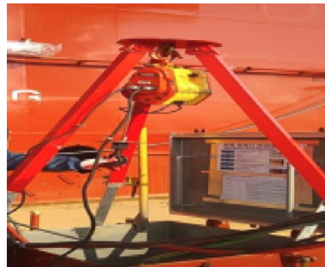
구조용 삼각대 설치
