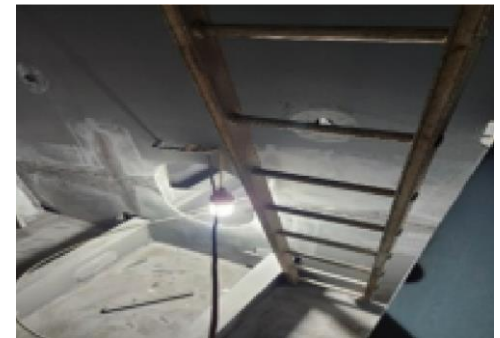
수직통로 조명 설치
