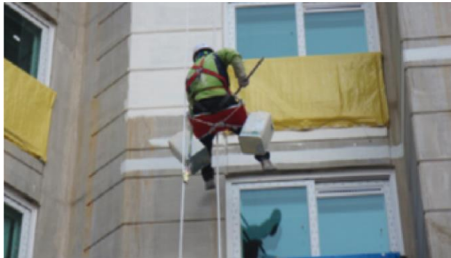
건축물 외벽 도장(달비계)
