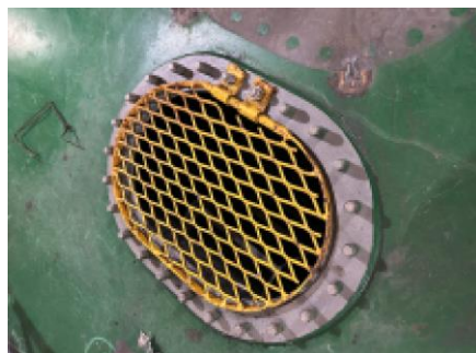
개구부 덮개 설치
