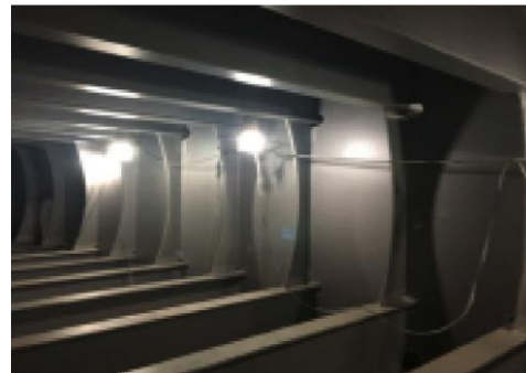
작업공간 조명 설치
