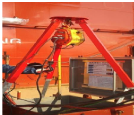
구조용 삼각대 설치
