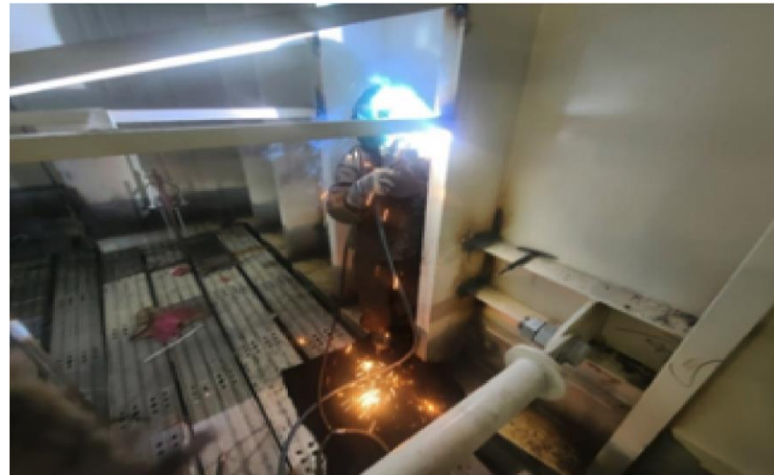
작업발판 위 용접
