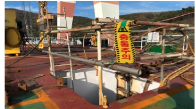
개구부 안전난간 설치
