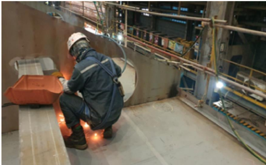
블록 상부 용접
