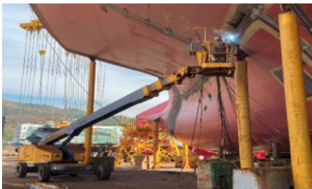
고소작업대 위 용접
