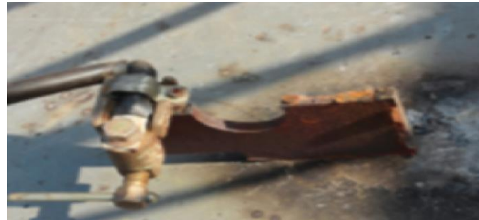
부재 용접 후 모재와 어스클램프 체결
