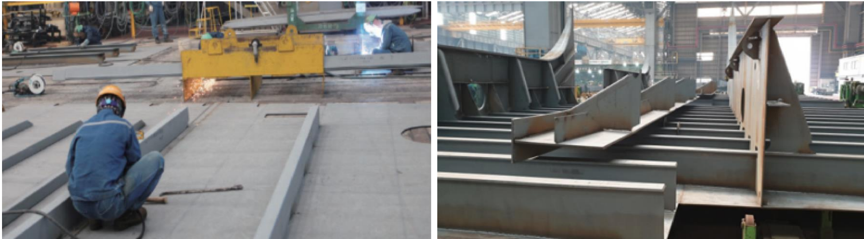
부재 용접, 취부 작업
