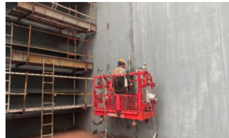
곤돌라 위 용접
