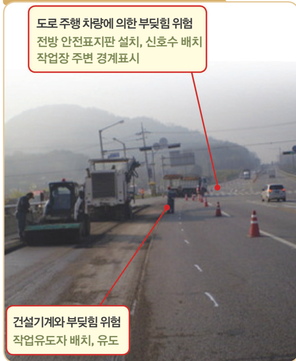
도로 유지, 보수 공사
